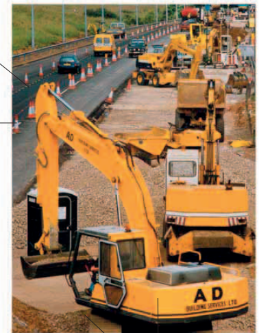
замена дорожного покрытия zamena dorozhnogo pokrytiya resurfacing
