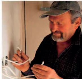
электрик elektrik electrician
